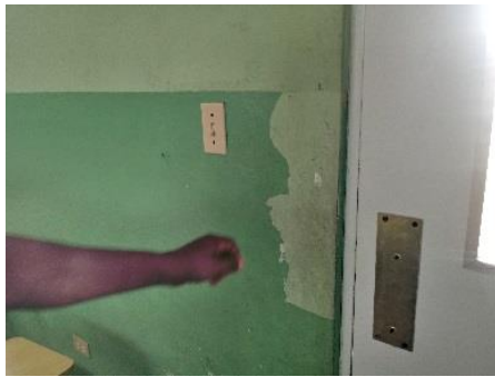
Foto presenta dos casos el desprendimiento de pintura y el manubrio de puerta, no se nota bien, pero la puerta tiene gran cantidad de abolladuras pequeñas realizadas por alumnos, con algo metálico. Esto en las aulas existentes rehabilitadas
