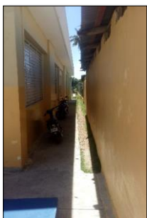
Vista lateral derecha modulo de aulas
