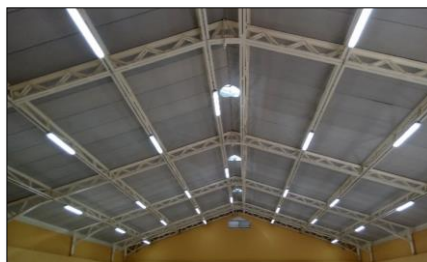
Vista interior comedor
