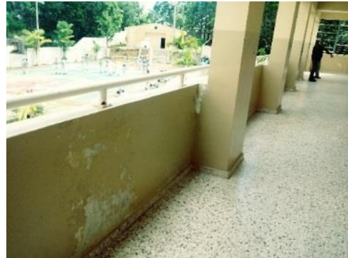
Foto presenta dos casos el desprendimiento de pintura y el manubrio de puerta, no se nota bien, pero la puerta tiene gran cantidad de abolladuras pequeñas realizadas por alumnos, con algo metálico. Esto en las aulas existentes rehabilitadas
