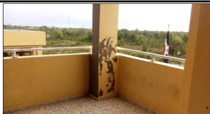
Vista condicion de pintura
