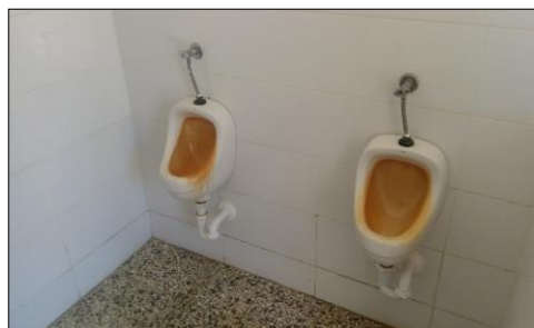
Vista condicion baños
