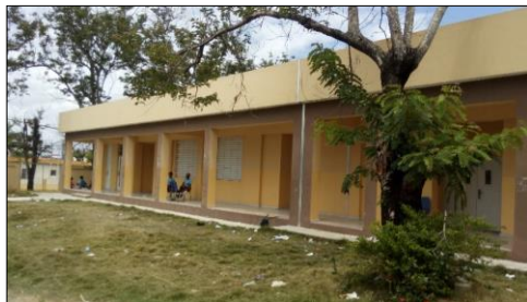
Vista frontal modulo de laboratorios
