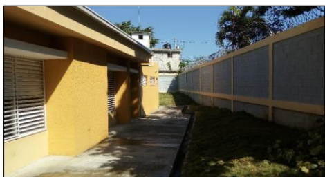
Vista lateral derecha comedor
