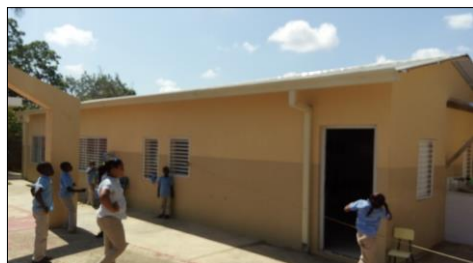
Vista lateral derecha comedor
